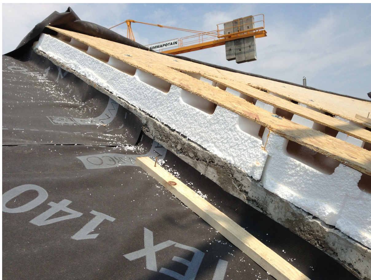
Pannello posato in opera, prima di essere rivestito.
