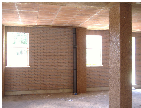
Rivestimento in sughero di pilastri interni (per ponti acustici) e della parte inferiore delle travi di bordo (per ponti termici)
